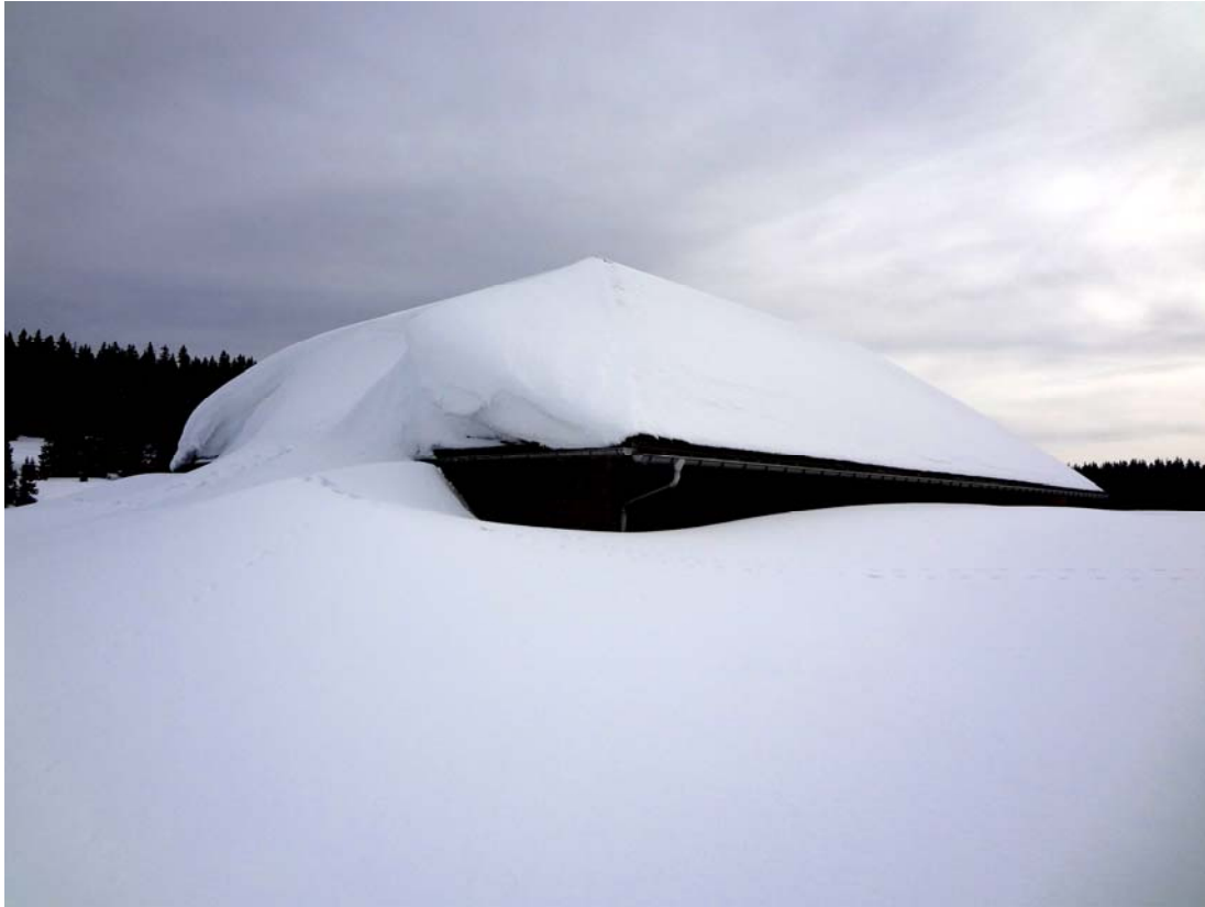
Chalet de la Sèche des Amburnex
